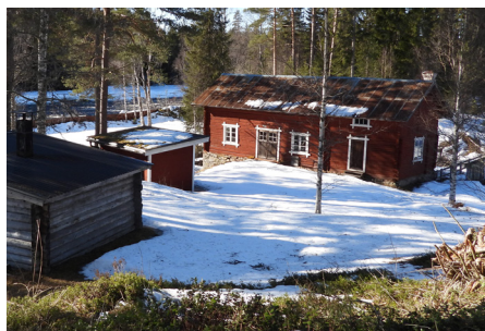
Kvarnhuset är väl bevarat. Kvarnkammaren längst till höger i bild.
